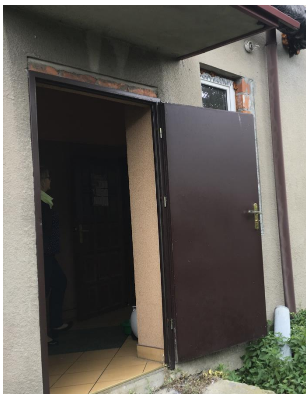
fot. 9 Istniejąca stolarka drzwiowa stalowa – Obiekt nr 2
