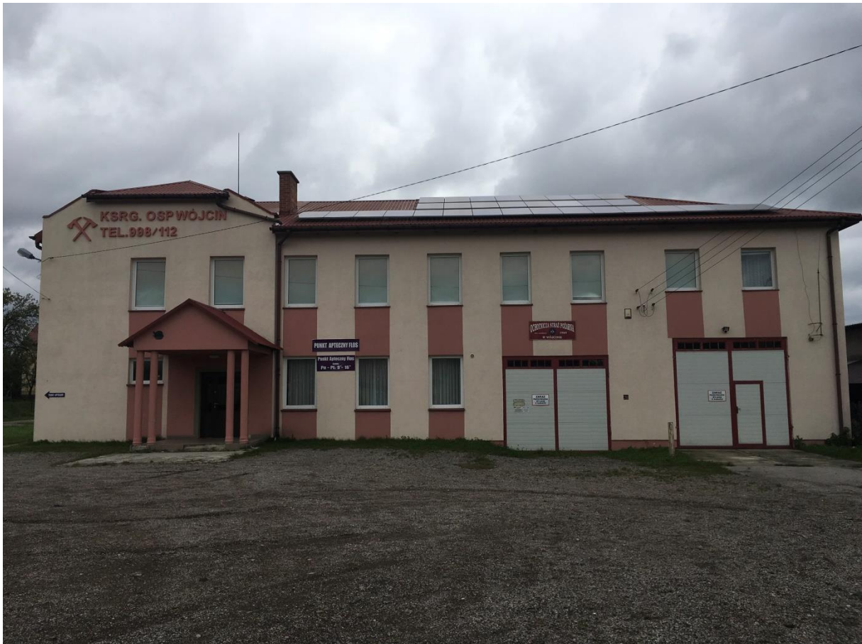
fot. 10 Istniejąca stolarka drzwiowa – Obiekt nr 3
