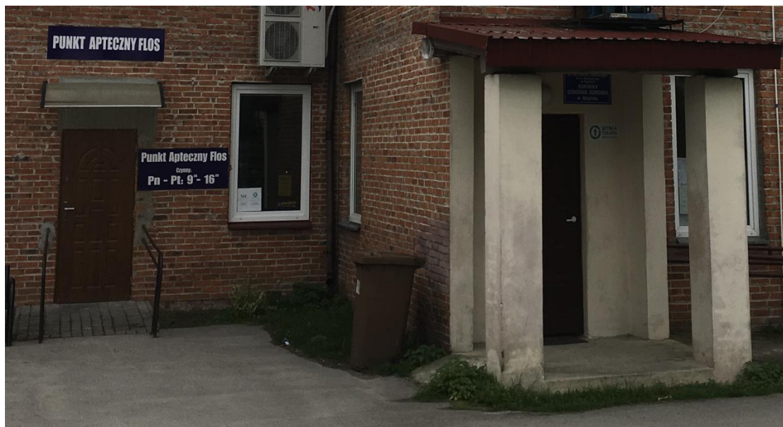
fot. 11 Istniejąca stolarka drzwiowa – Obiekt nr 3
