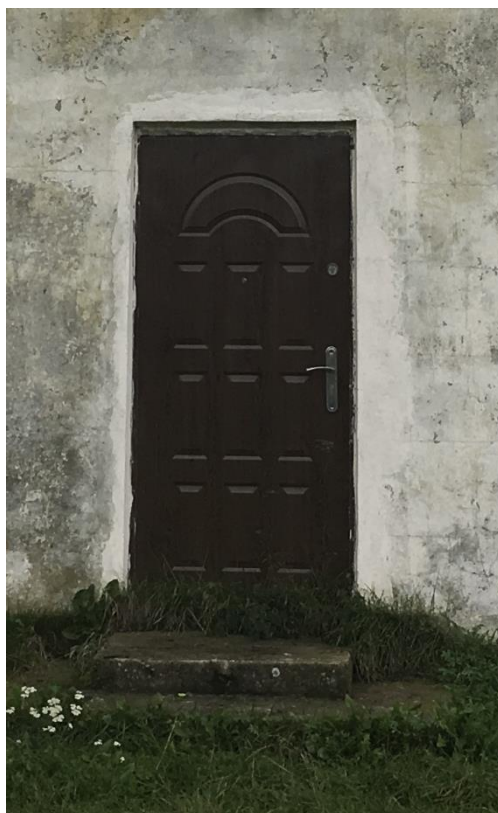
fot. 13 Istniejąca stolarka drzwiowa stalowa – Obiekt nr 4
