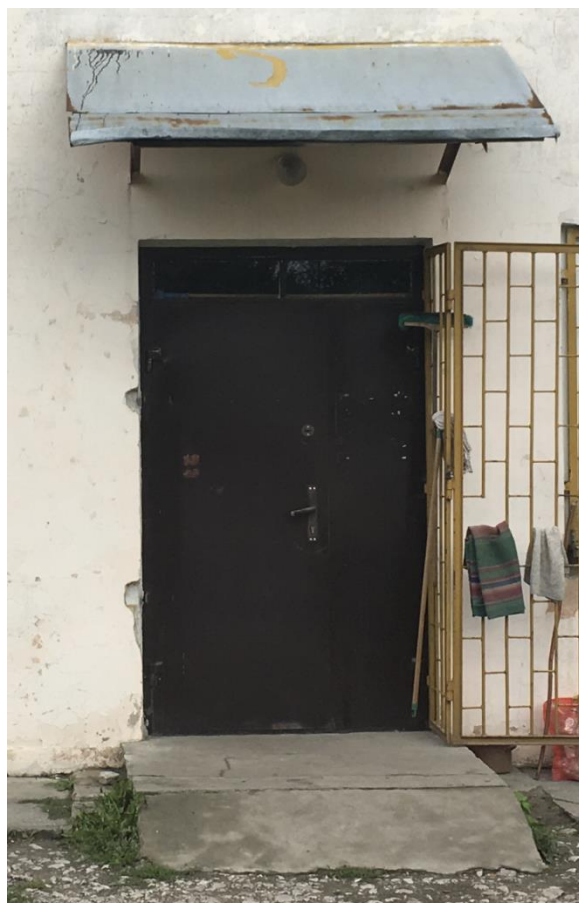
fot. 12 Istniejąca stolarka drzwiowa stalowa – Obiekt nr 4
