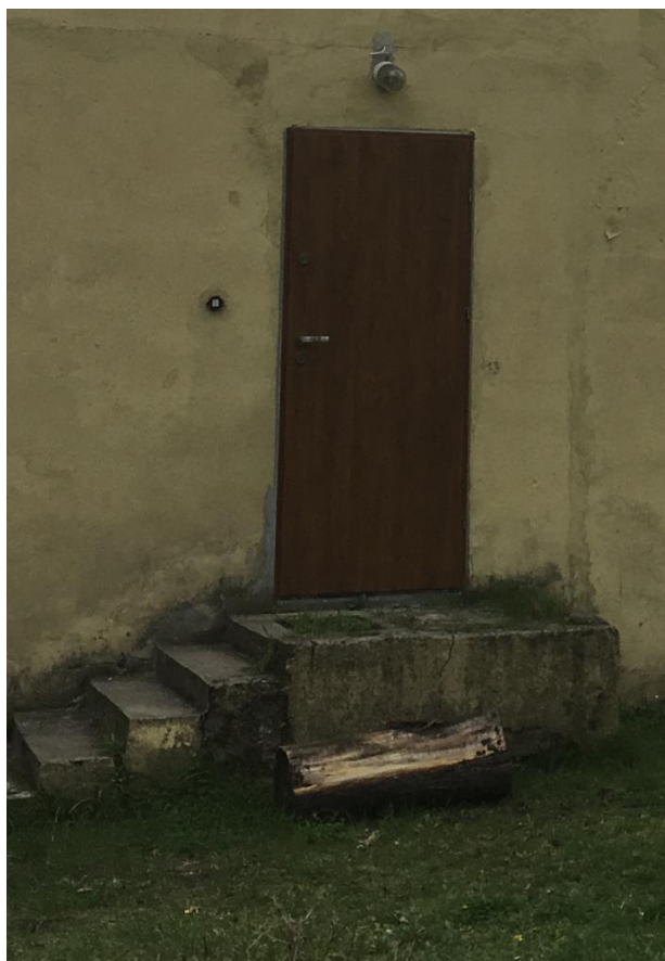
fot. 8 Istniejąca stolarka drzwiowa stalowa – Obiekt nr 1
