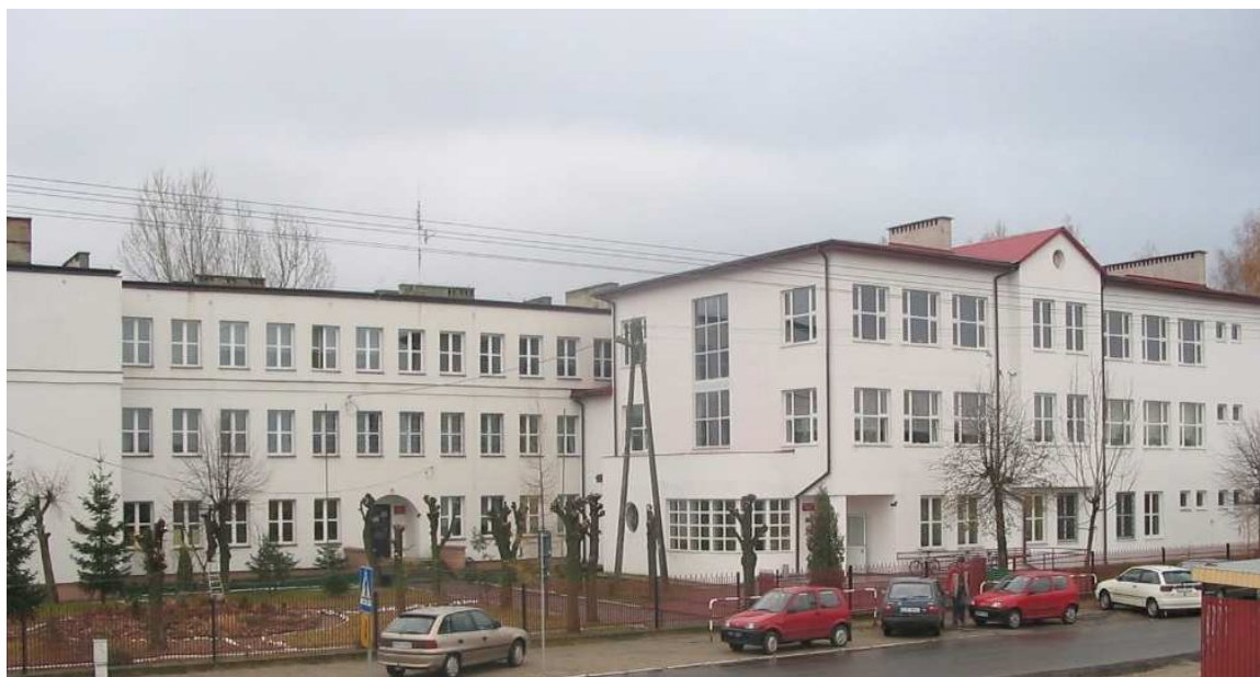
Zdjęcie 5. Budynek Zespołu Szkół Samorządowych w Paradyżu
